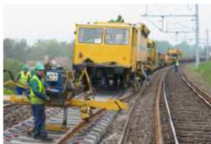
Longs Rails soudés sur traverses béton
